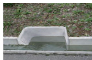
環境に配慮した道路側溝の例
