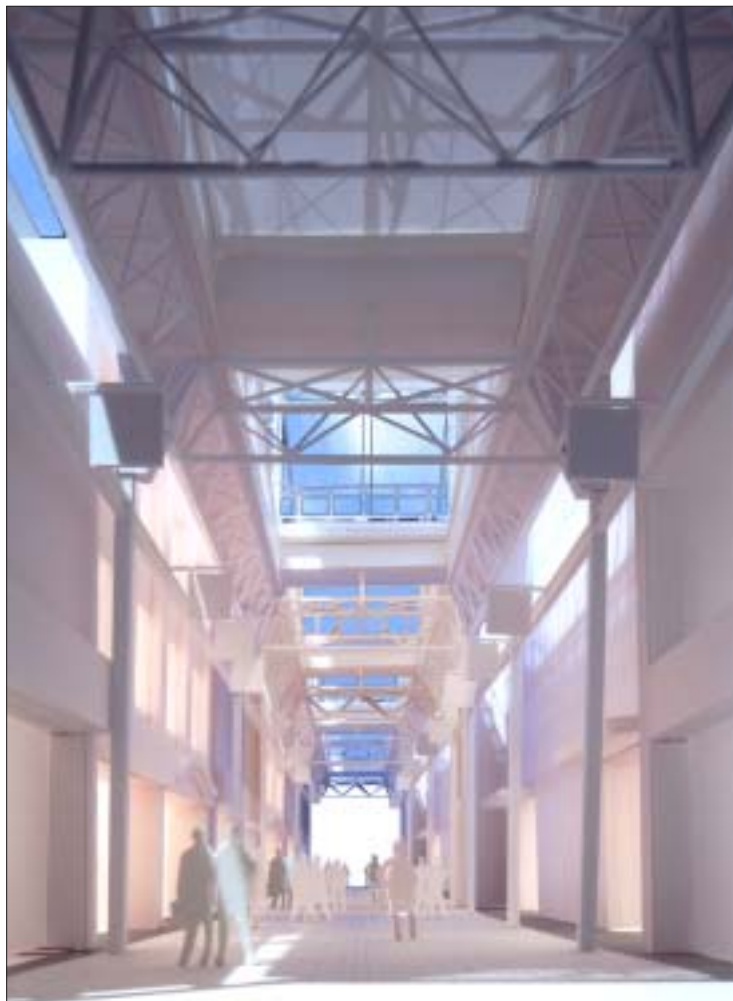
▼ 開閉する膜屋根（開放時）
